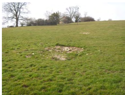
Second effondrement à l'arrière de l'exploitation agricole chemin de Noyers à proximité de la première.
