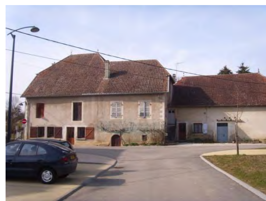
Construction mitoyenne sur limite séparative
