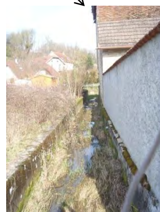
Aménagement autour du ruisseau de Corcondray dans le village
