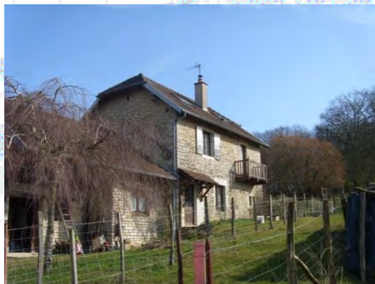
Ferme rénovée avec un toit en demi-croupes
