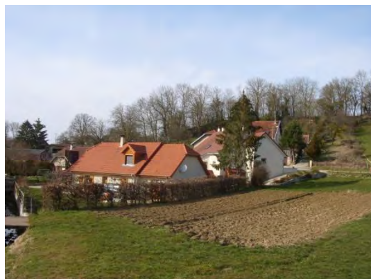
Construction intermédiaire avec façade claire et toit rouge en demi-croupes
