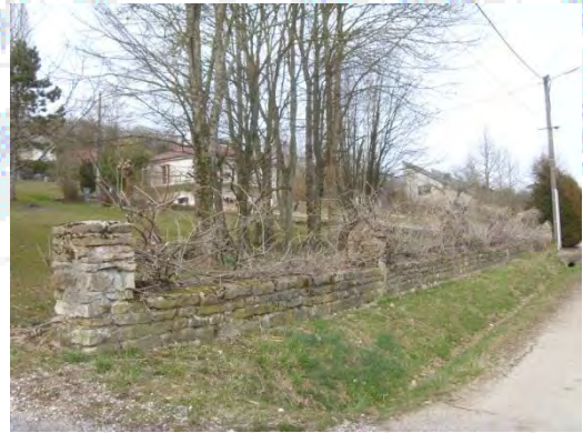
Mur en pierres
